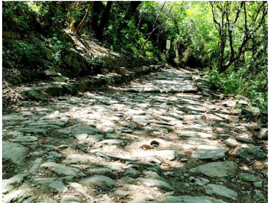
Fig. 1 – Il tratto di strada meglio conservato
