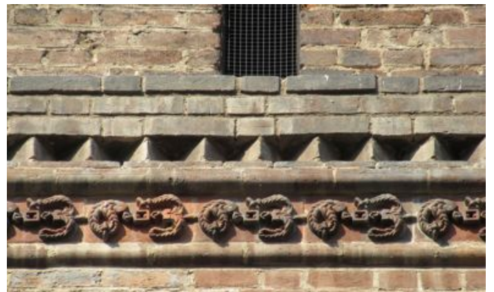
Duomo di San Giovanni, campanile, fasce marcapiano
